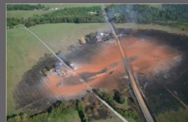
Conséquences d'une fuite sur une canalisation de transport, Appomattox (USA), 14 septembre 2008 (source pstrust.org).
